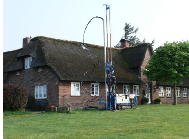
Abteufen einer Edelstahlsonde (Foto Pumpen-Strebe)
