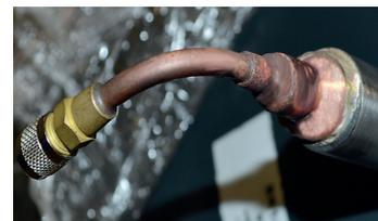
**Schraderventil:** Unter Druck stehendes System, bei Montage der weiterführenden Leitungen ist eine einfache Dichtheitsprüfung möglich.
